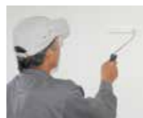
シーラー全面塗り(2回塗り)
